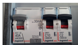
Disjoncteur remonté
