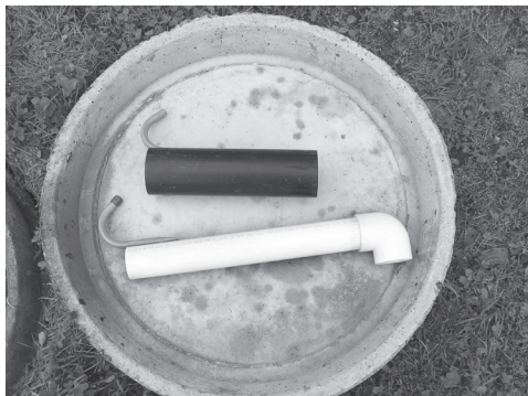
FIGURE 12-7 : INSTALLATION DE LA CRÉPINE DANS LE DISPOSITIF D'ÉCHANTILLONNAGE
